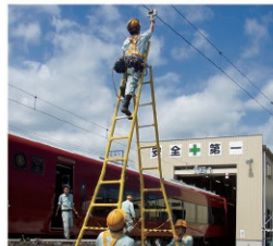
①電力設備点検の様子
